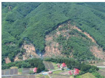
いちのせきしいちののぼら 岩手県一関市野々原地区 （民有林直轄地すべり防止 事業による復旧に着手）
