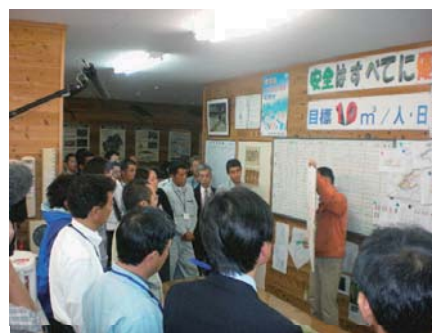
現場の工程管理について説明
