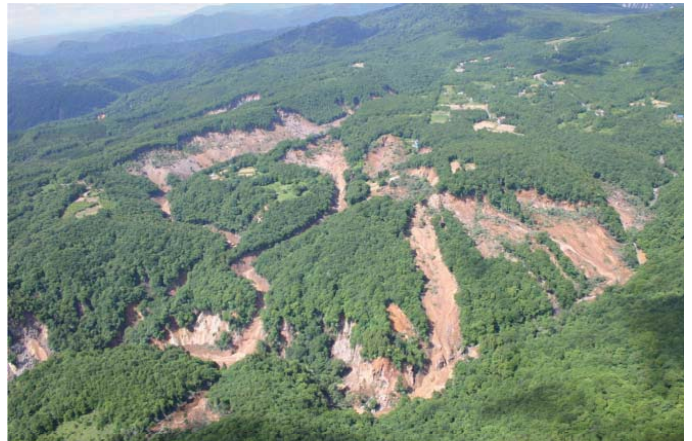
平成20年に発生した山地災害
