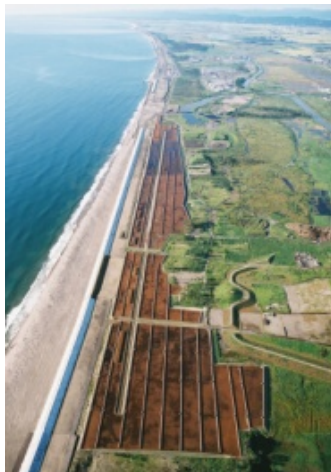
〔 生育基盤の整備のための盛土工事 〕
