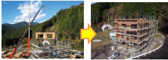
平成26年3月に高知県内で竣工した国内初のCLT建築物は、構造部分の建て方が正味2日間で完了(上図)。他にも平成26年度中に北海道、福島、岡山などで新たなCLT建築物計8棟が竣工。
