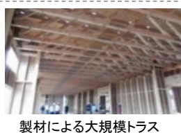
製材による大規模トラス
