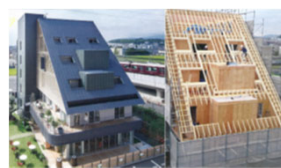
木造非住宅建築物 (※JAS構造材を活用した商業ビル)
