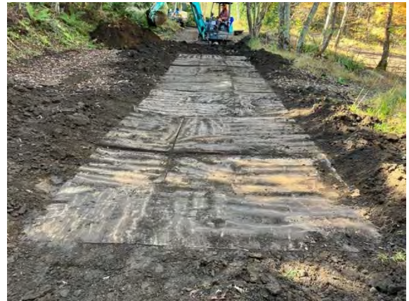
写真 3 2019 年施工の構造用合板 (掘削深さ 200mm、2022 年 10 月撮影)
