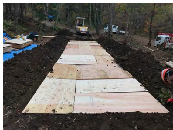
写真1 構造用合板の施工状況 (掘削深さ 200mm、2019年 11月 7日)
