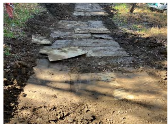
写真 5 2020 年施工の構造用合板 (掘削深さ 100-150mm、2022 年 10 月撮影)
