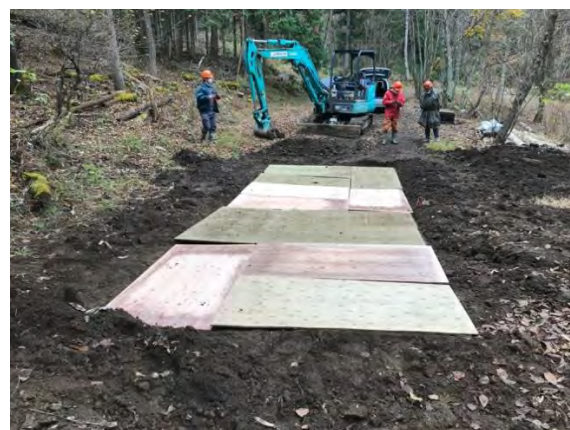
写真2 構造用合板の施工状況 (掘削深さ 100-150mm、2020年 11月 6日)
