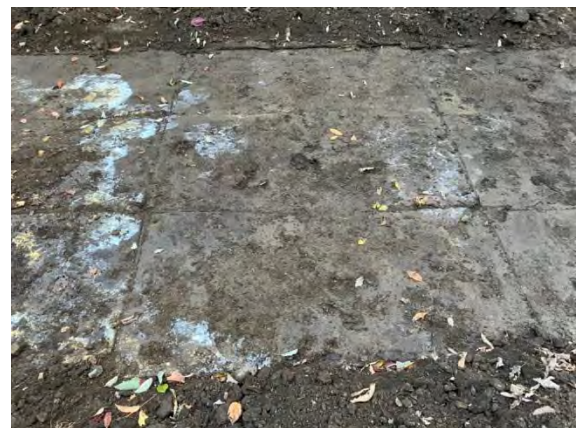
写真 4 構造用合板を除去した状況 (2019 年施工部分、2022 年 10 月撮影)
