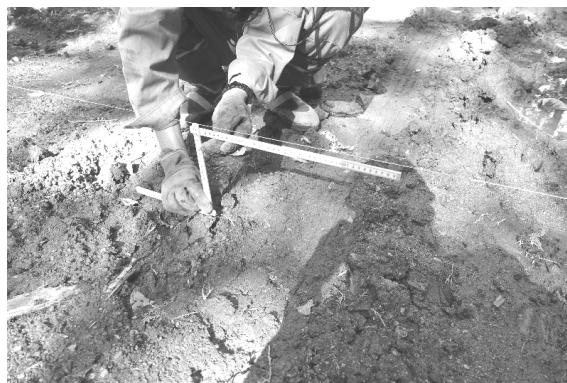
図-2 路面高の計測
