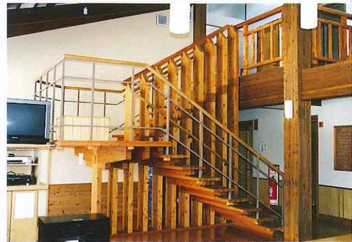
階段柱に階段桁が相欠きで嵌め込まれ、段板を片持ちで受けています。
