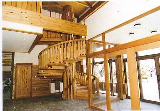
2本の柱からの片持ち梁を基本ユニットとして螺旋階段を構成しています。
