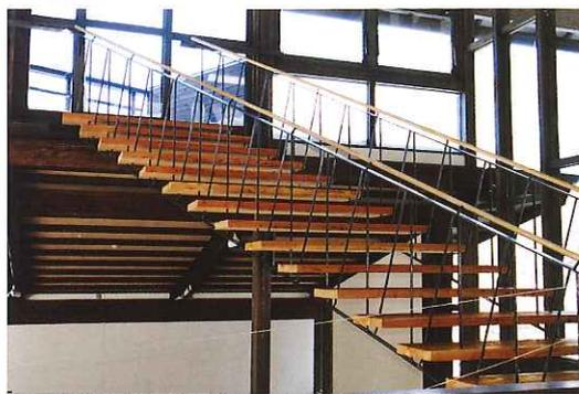
木製段板と手摺部鉄鋼によるトラスを組み合わせて、吊り橋のように軽やかに架け渡されています。
