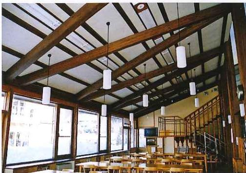
共用部の屋根は水平トラスとして、柱・梁を極力細くし、開放的な共用空間としています。
