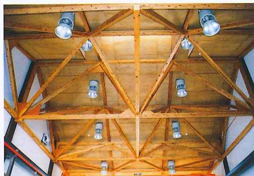
水平、垂直、斜面の各トラスを組み合わせて立体トラスとし、接合部は合板プレートを使用しています。
