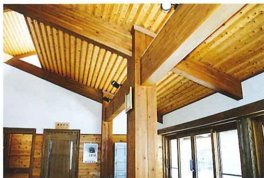
鋼板やボルトを使わず、伝統技法を応用した「通し貫+木栓」接合としています。
