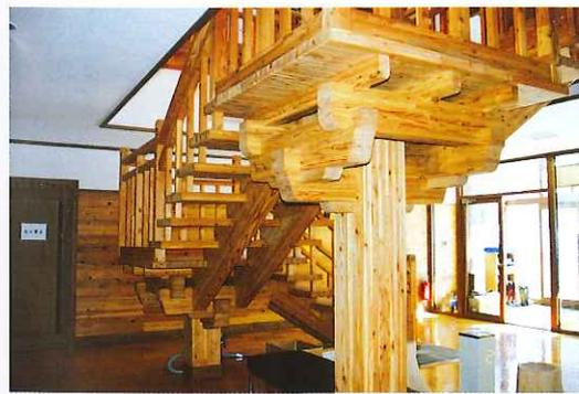
支持柱は合わせ柱と天秤梁による組み物として、階段を受けています。
