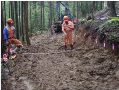
軟弱路盤への丸太埋設効果の測定
