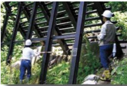
写真－2 山地防災ヘルパーによる治山 施設の点検
