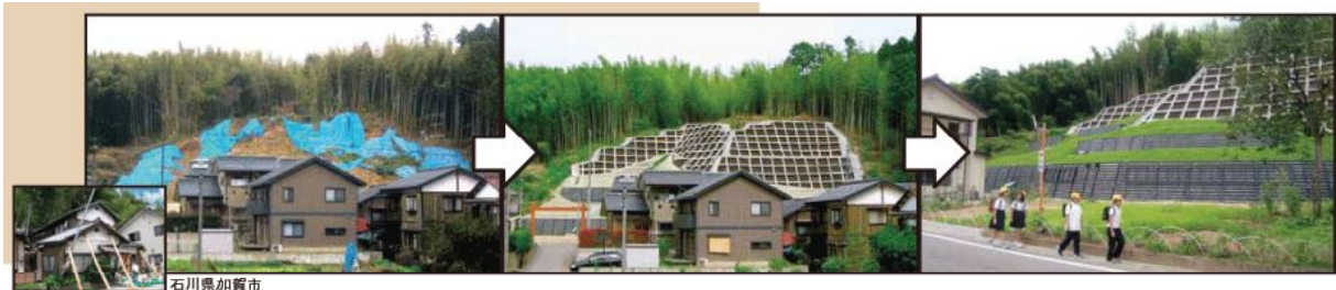
写真－1 崖崩れの復旧
