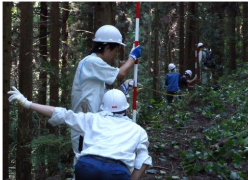
～林道研修での測量実習～
