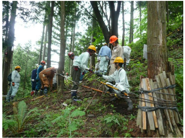
～「集材架線」でガイライン張り～
