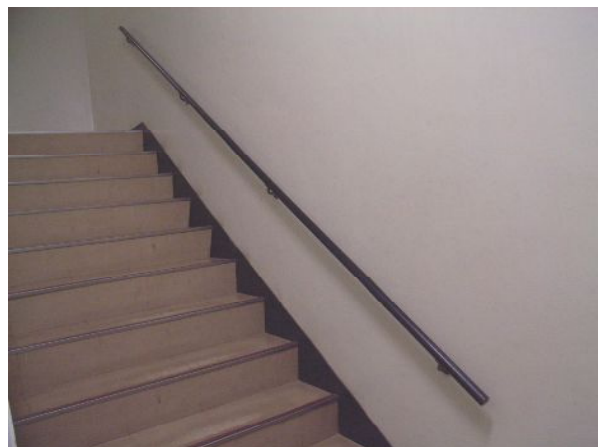
階段に設置された手摺
