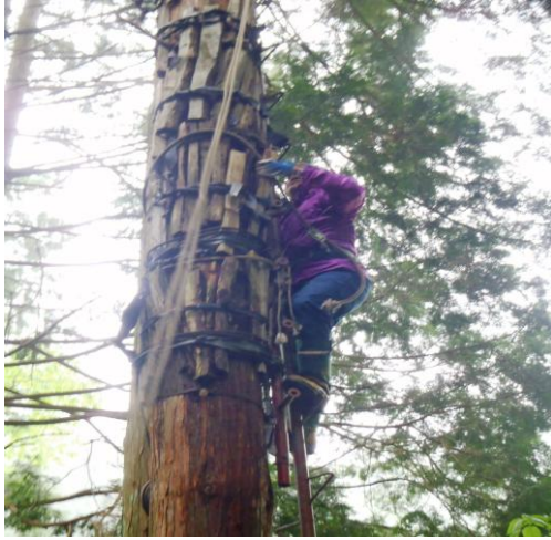
●高所での架線のサドルブロック設置作業
