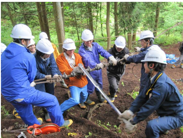
●集材架線研修において大型レンチで主索を固定する専攻科生(林業機械化センター)
