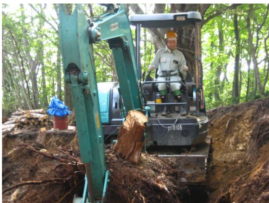
●森林作業道を作設する研修生
