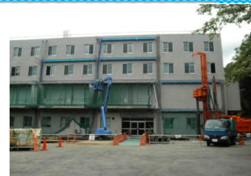
●いよいよ杭打ち工事の開始です
