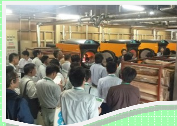
“道志の湯”にて薪ボイラー（橙色の装置）の説明を受ける
