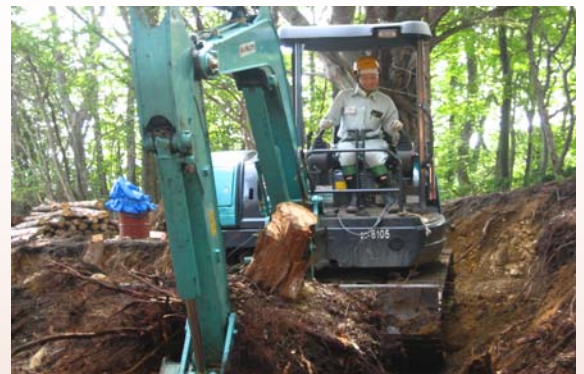
作業道作設実習の風景
