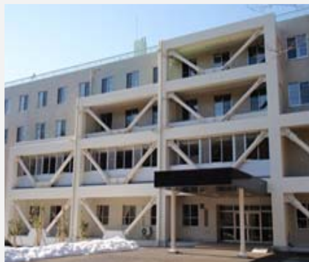
耐震工事完成後の庁舎外観
