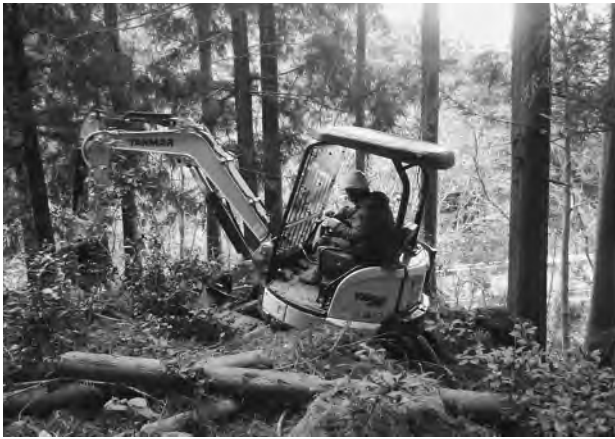
作業道作設（壊れない道づくりを目指して）
