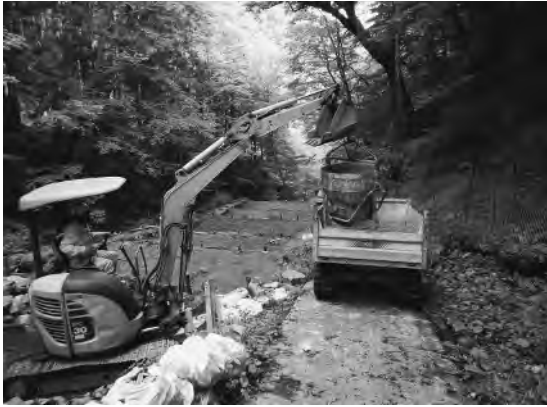
ワサビ田の石垣の復旧作業では、メンバーが重機を持ち込み、巧みに操作した
