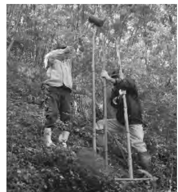
簡易柵の設置。伐り出した竹を地面に打ち込む
