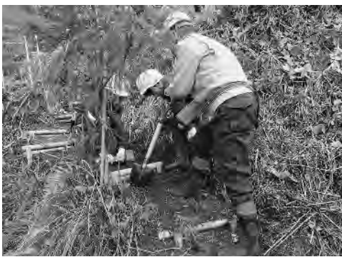
階段設置体験。できあがった時、嬉しそうにしていた
