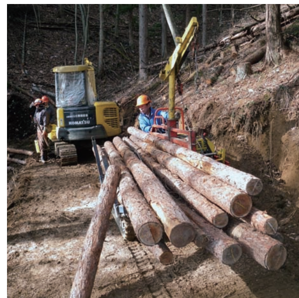
作業道作設中現場の様子
