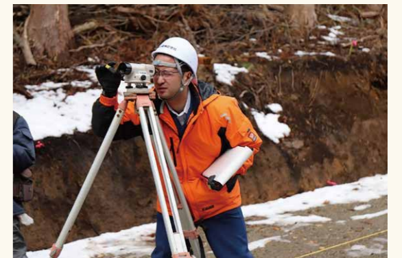
林道を検査中の様子。設計どおりに完成しているか確認します。
