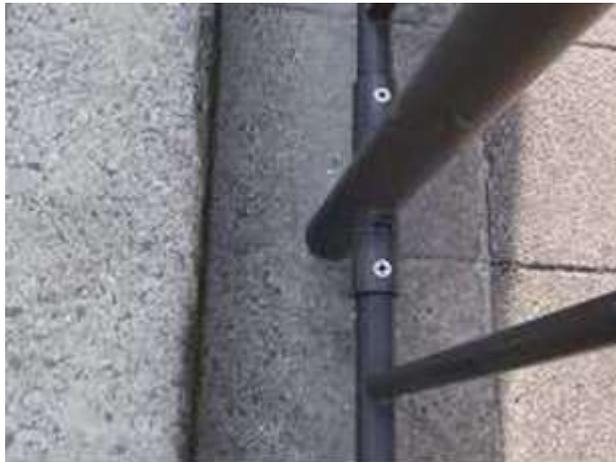
写真のように、ガードレールの柱と道路境界のブロックとの間に、無駄なスペースのように思われるすき間が「かぶり厚」の寸法である。
