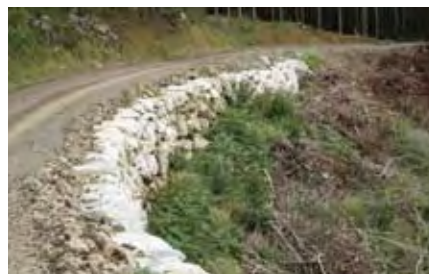
間伐遅れ林に精力的に林道を開設し、間伐を推進
