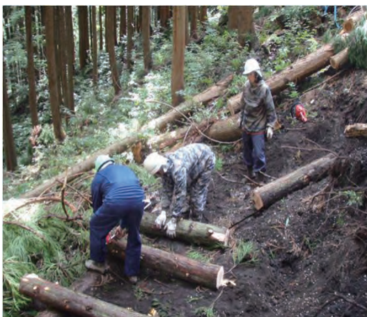
写真-3 作業路開設風景
