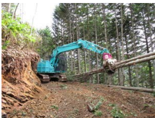
フェラーバンチャザウルスによる伐開・地山掘削
