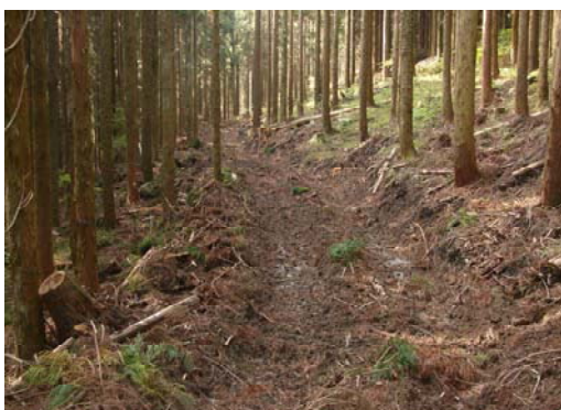
既設作業路を利用した低コスト路網の改良
