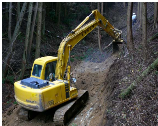
バックホウによる集材路開設
