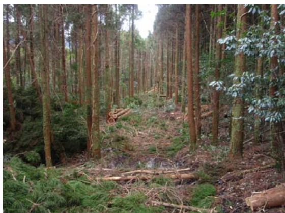
作業路開設状況 (枝条を敷いて路面を保護している)
