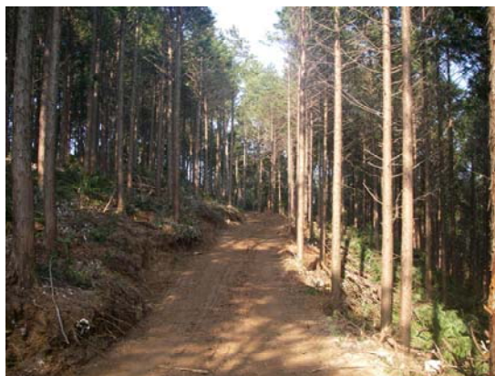
作業路開設状況
