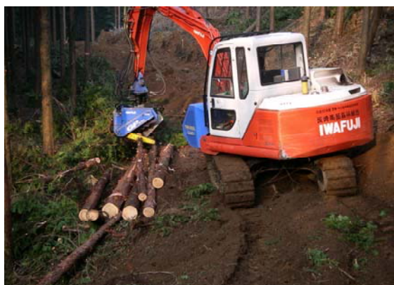
プロセッサによる支障木の造材
