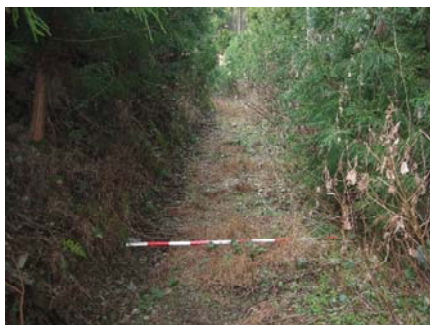
小型林内作業車用の作業路
