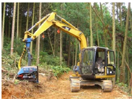
拡幅して高性能林業機械を使用
