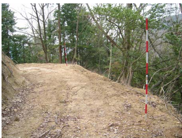
作業路作設状況
