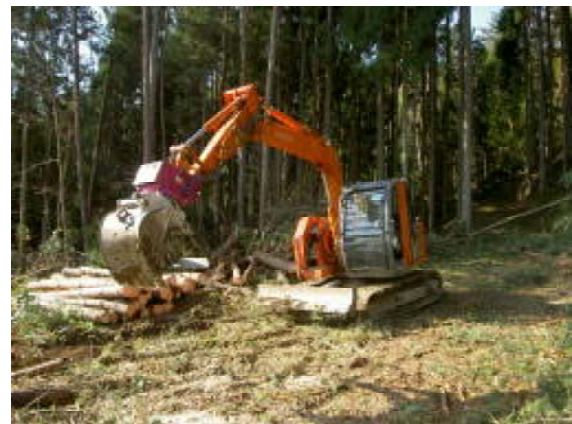
作業路の開設と支障木の整理
