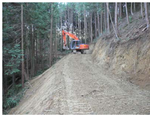
作業路開設による集材準備
