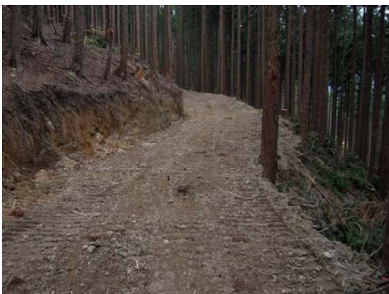
【低コスト作業路の作設】
