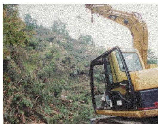
スイングヤーダによる下荷集材
