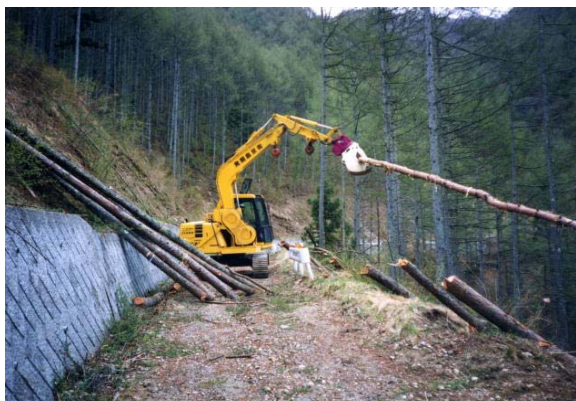
本県の間伐作業に初めて導入された スイングヤーダ (ザウルスロボ仕様)
