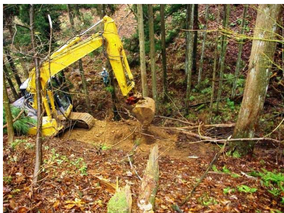
作業路作設状況
