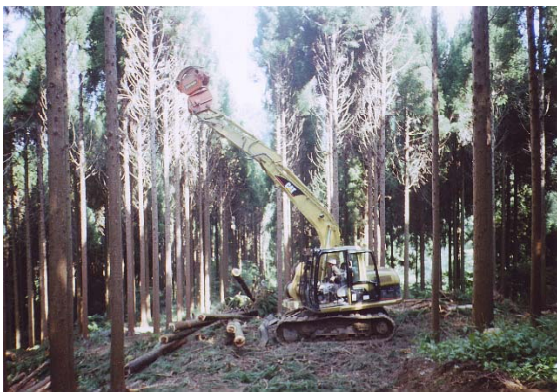
写真1 スイングヤーダによる集材
