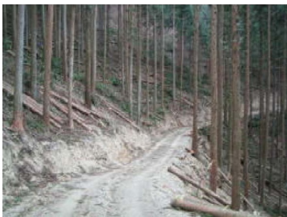
作業路の開設状況
