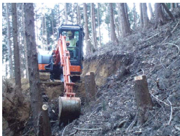
①バックホウによる作業路開設状況
