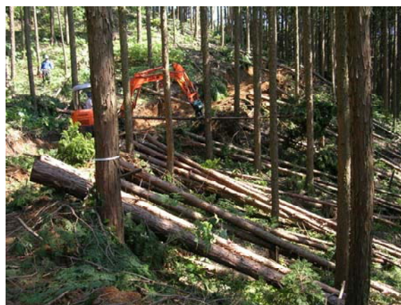
②グラップル付バックホウによる木寄せ状況
