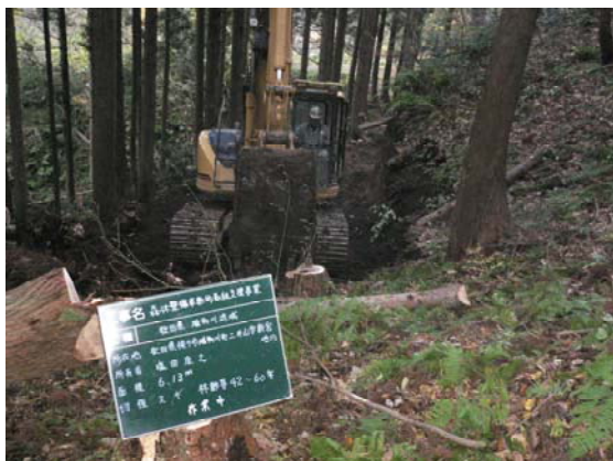
バックホウによる作業路作設
