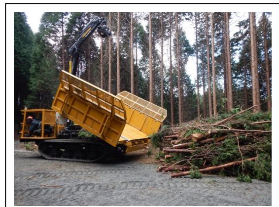
【搬出した枝条等の積降ろし】
