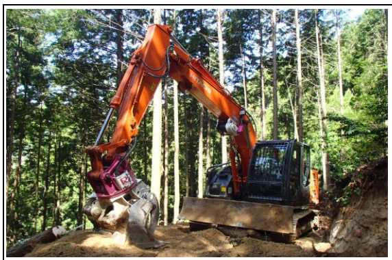
【フェラーバンチャによる作業道開設】
