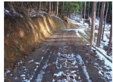
【砕石を敷きつめた作業道】
