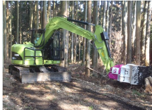
【フェラバンチャウルスによる作業路開設】
