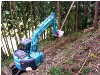
【フェラーバンチャーザウルスによる作業道作設】
