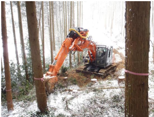
【ハイブリッド機による作業道の開設】
