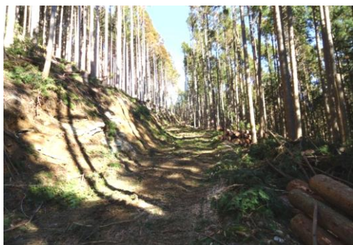
【作業路の開設状況】
