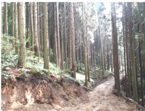
【作業道の開設状況】
