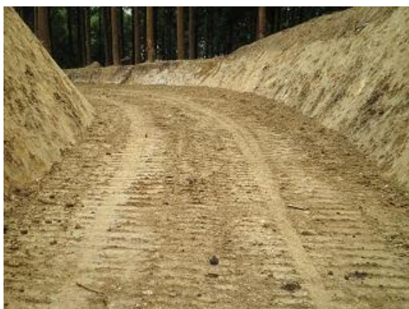
【森林作業道開設状況】
