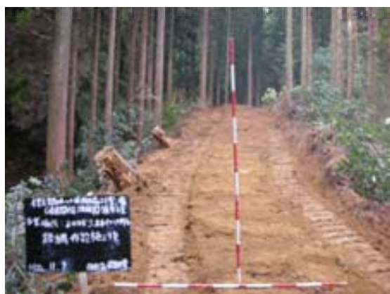
地形に追従した森林作業道の作設
